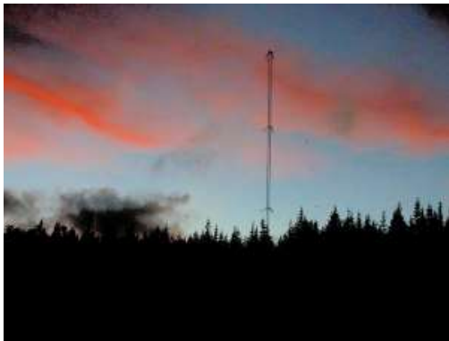
Antennemast John Craig (VO1NA)
